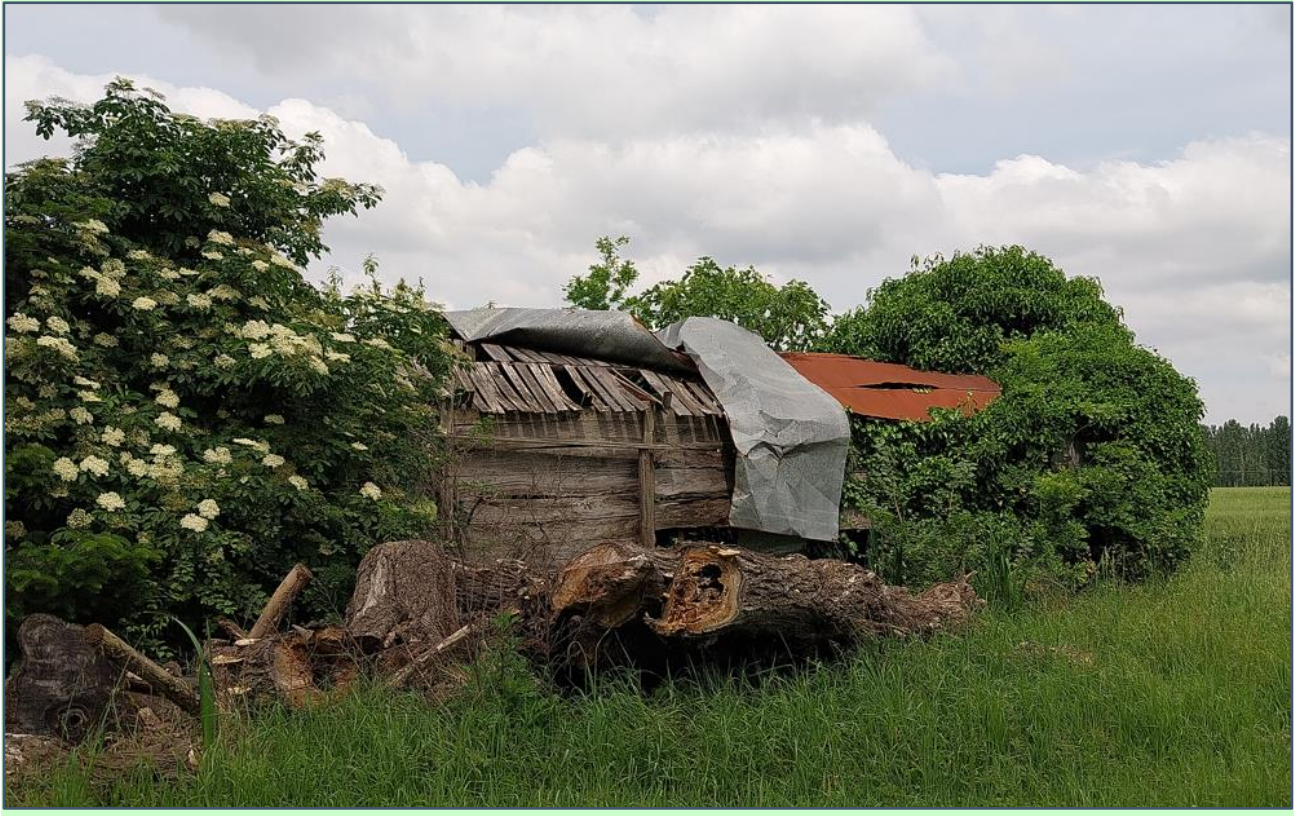
Fabbricato ad uso magazzino – mappale 283
