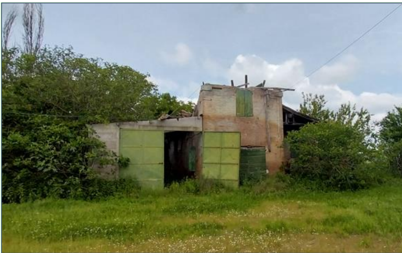
Fabbricato ad uso magazzino-proservizi + Fabbricato ad uso ricovero macchine agricole (sub 3)
