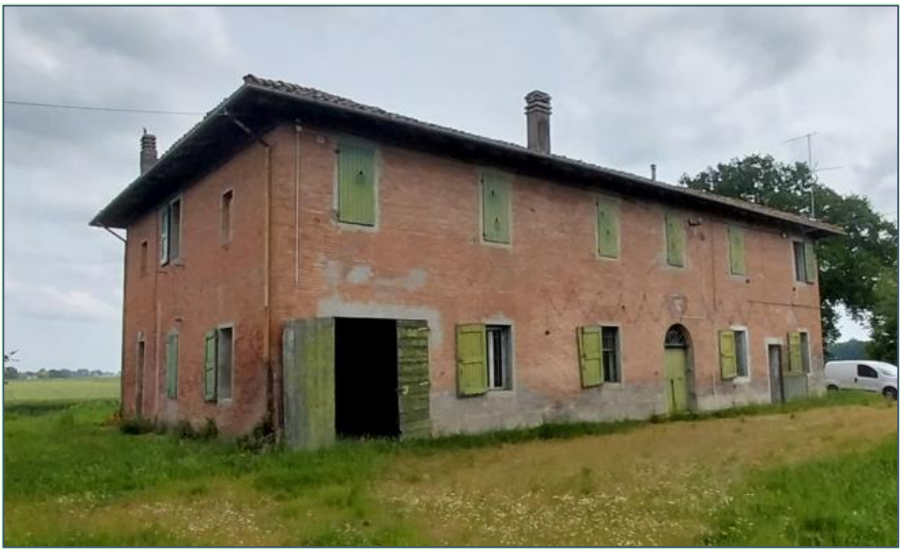
Fabbricato abitazione (sub 1)
