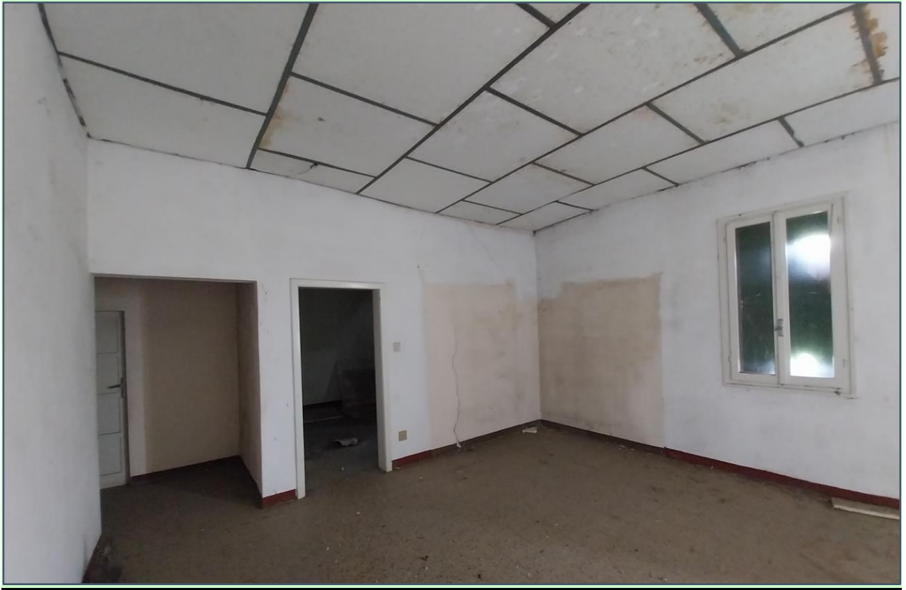
Fabbricato abitazione – interno piano primo
