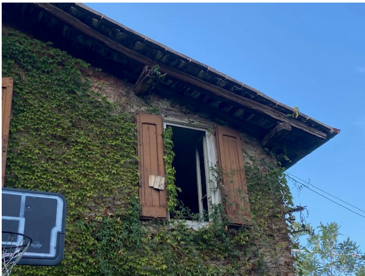
FOTO 10 – PARTICOLARE SPORCO DI GRONDA E INFISSI
