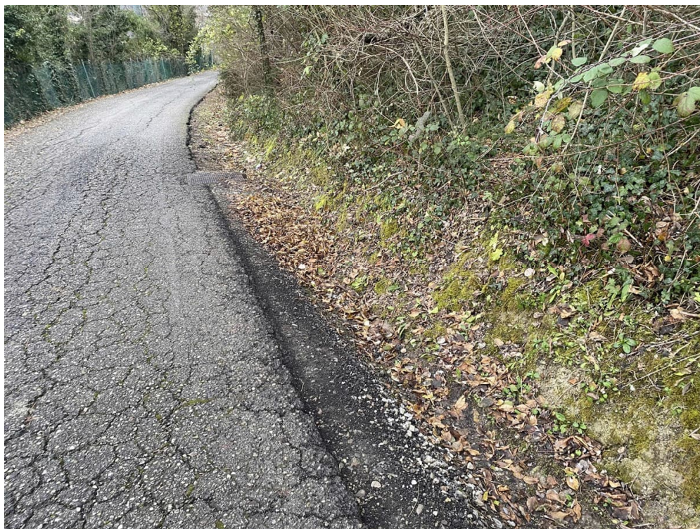
Foto 6 – Ciglio e fosso di monte della strada
