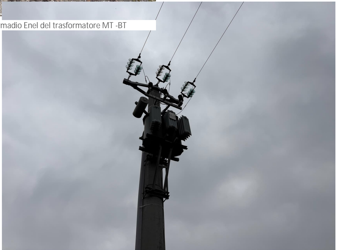
Foto 14 – Trasformatore MT-BT
